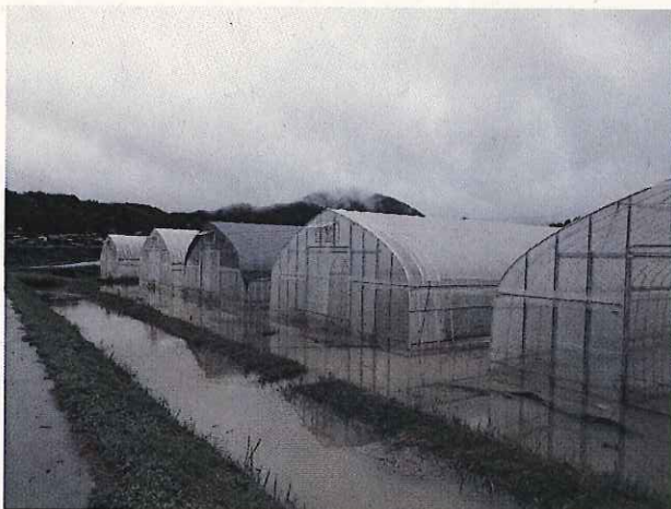
株式会社農夢(綾部市位田町)の 水菜ハウスの被災状況(58棟冠水)
