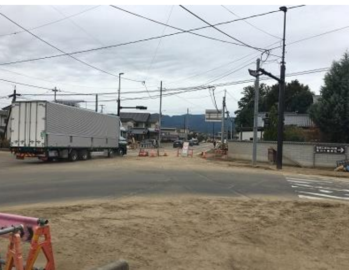
伊達市の浸水現場
