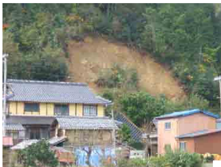
急傾斜地崩壊 (舞鶴市)
