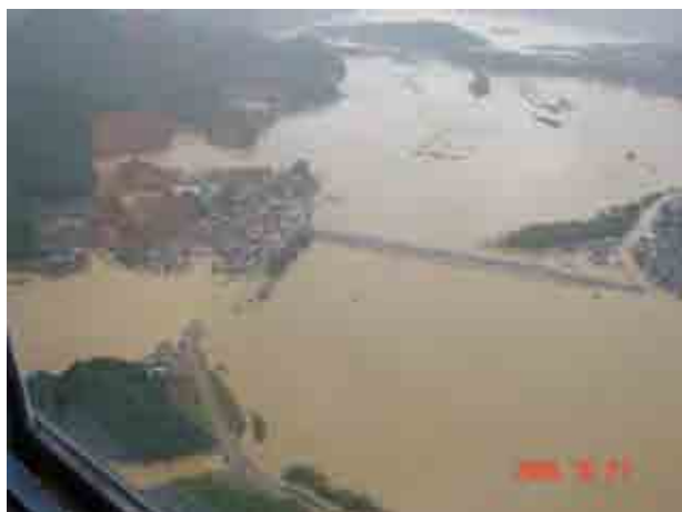
由良川の出水による大雲橋付近の国道175号冠水
