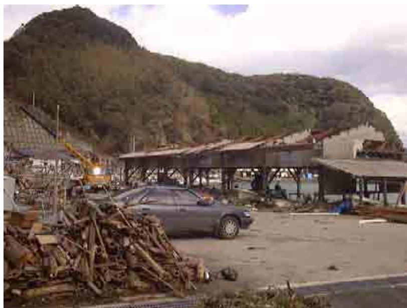
漁業共同施設の損壊（伊根町）
